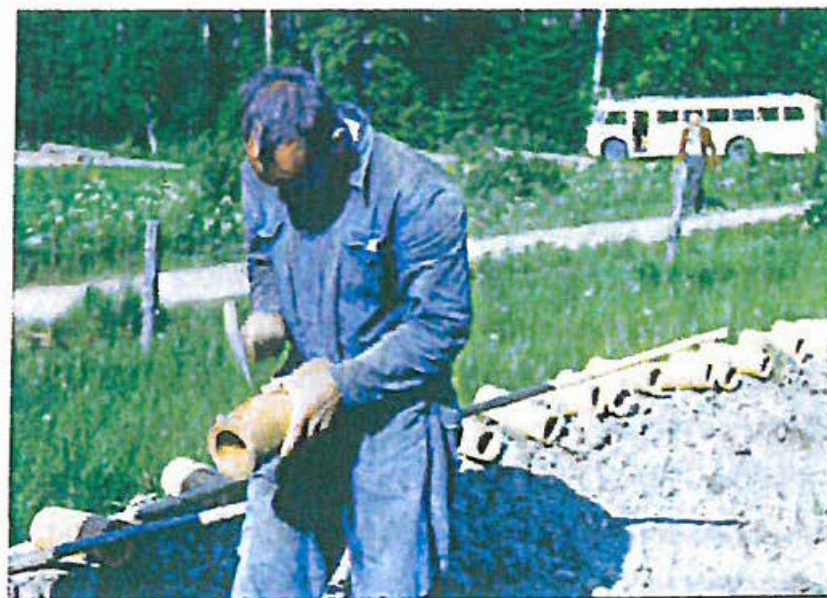
FIGUR 2b. Drængrøft med drænrør, der er parat til at blive lagt i jorden.
